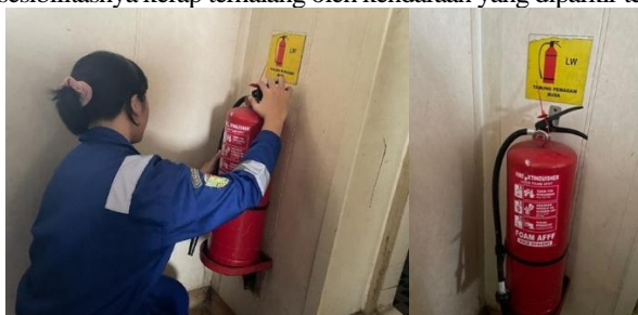
Gambar 2. Pengecekan Kondisi Fisik APAR Foam dan Kondisi yang Baik
