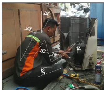
Gambar 4 Perbaikan Unit Outdoor AC
