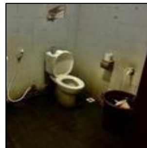
Gambar 2. Kondisi toilet pada bagian operasional
