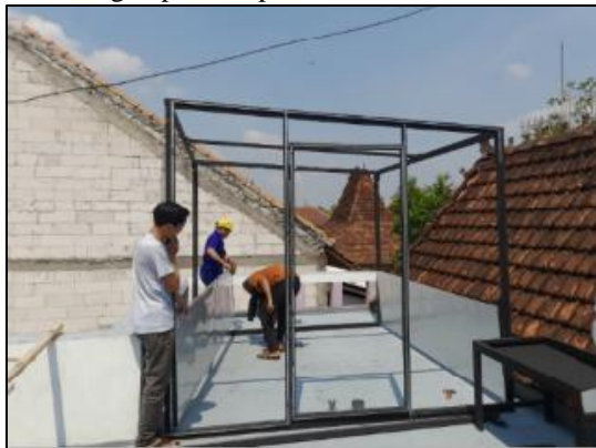
Gambar 6. Fabrikasi Pengering Cerdas Berbasis IoT
